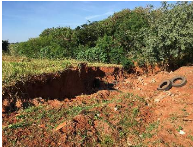
Foto 3.73 – Erosão na área do antigo lixão
