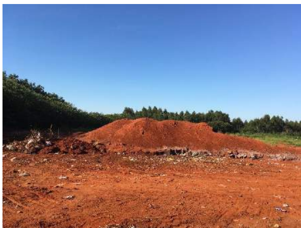
Foto 3.47 – Vista geral do aterro controlado municipal
