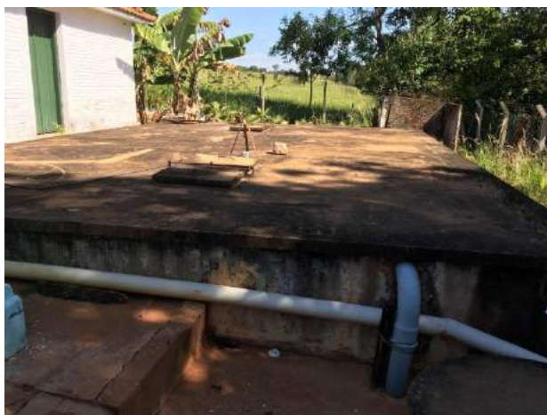
Foto 3.16 - Identificação do Reservatório: RSE 01
