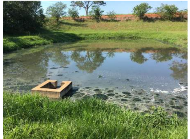
Foto 3.39 – Vista geral da lagoa anaeróbia 03 ETE Cosmorama
