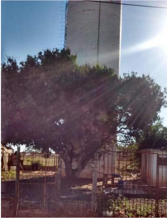
Foto 3.18 - Identificação do Reservatório: REL 03
