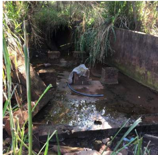
Foto 3.68 – Dissipador de energia
