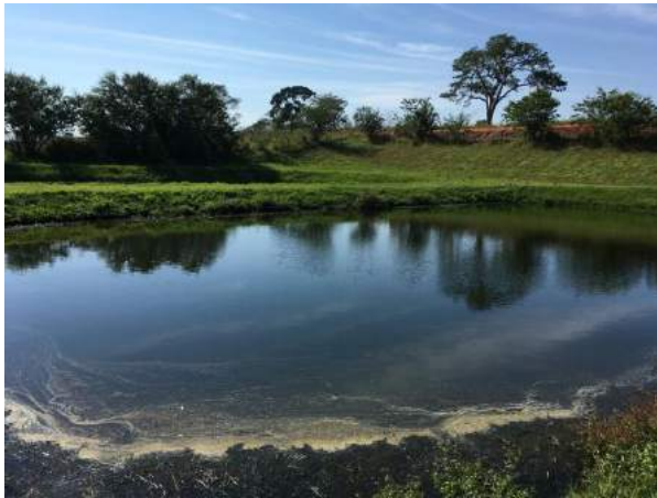
Foto 3.38 – Vista geral da lagoa anaeróbia 02 ETE Cosmorama
