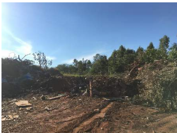
Foto 3.59 – Armazenamento dos resíduos de poda e capina no aterro controlado
