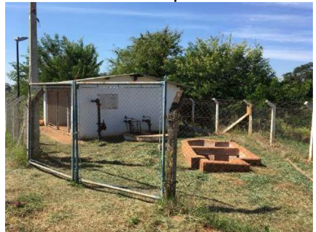
Foto 3.26 – Vista geral das unidades EEEB Área de Lazer
