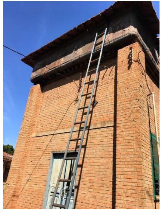
Foto 3.19 - Identificação do Reservatório: REL 04
