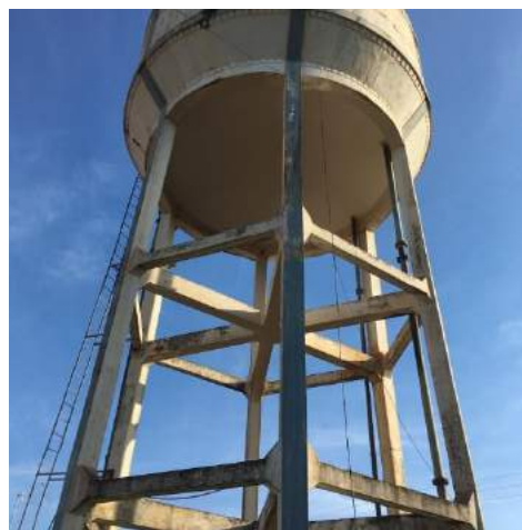
Foto 3.17 - Identificação do Reservatório: REL 02
