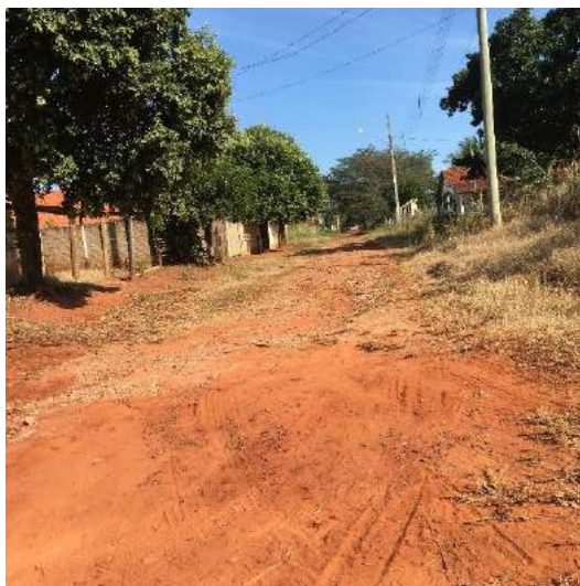
Foto 3.66 – Rua sem sistema de microdrenagem no Bairro isolado Vila Nova
