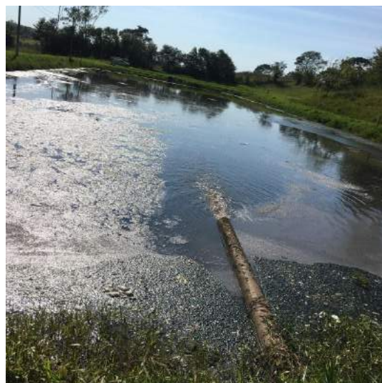
Foto 3.37 – Vista geral da lagoa anaeróbia 01 ETE Cosmorama
