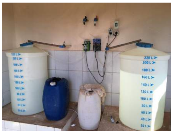
Foto 3.13 - Unidades de Fluoretação e Cloração
