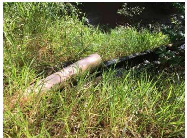
Foto 3.46 – Vista do efluente tratado sendo lançado na escada hidráulica ETE Vila Nova
