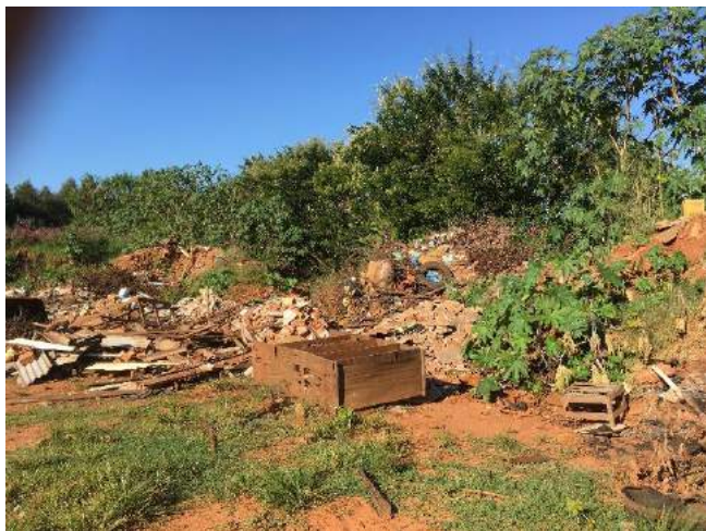
Foto 3.61 – Armazenamento dos resíduos de construção civil na área do aterro controlado
