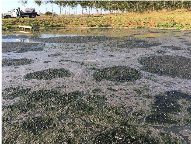
Foto 6.7 – Vista da presença de sobrenadante e placas de lodo desprendido do fundo na superfície líquida da lagoa anaeróbia
